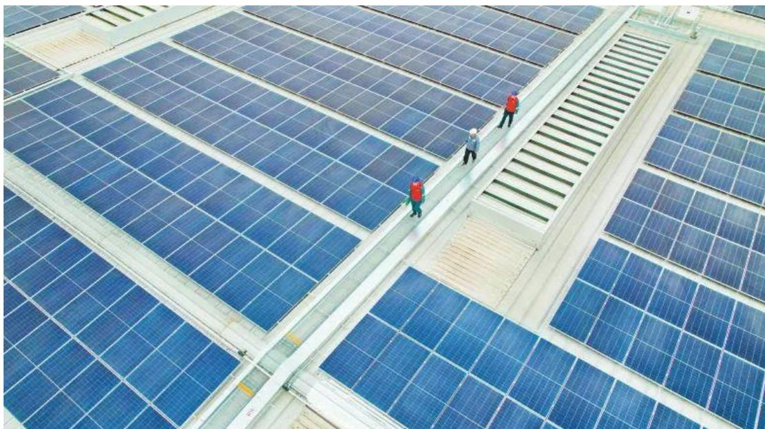
亚太森博（山东）浆纸二期分布式光伏项目充分利用新建投产的文化纸、生活纸9栋厂房屋顶（约13万平方米），选用当前最新N型Topcon双面585Wp组件，共计安装25590块光伏板，直流侧装机容量达14.97MWp，通过接入厂区10KV高压母线为文化纸、生活纸厂区输送绿电。
